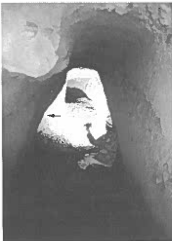
PERCORRENZA 1110 Interno il bypass: termine condotto 2. Sullo sfondo la prosecuzione interrata dello stesso. A sinistra (freccia) l'ingresso al condotto 3.
