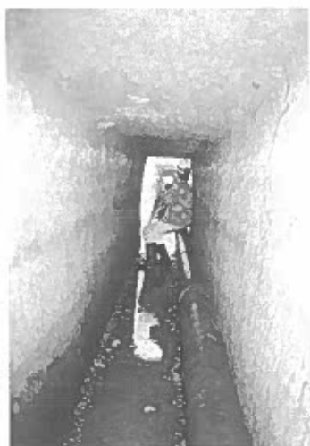
PERCORRENZA 1220 Prosegue la sezione rettangolare in rocce relativamente morbide.
