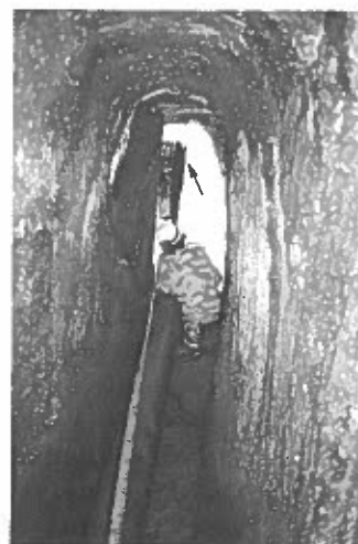
PERCORRENZA 1340 Interno deviazione. Sullo sfondo (freccia) si intravede la brusca deviazione a destra del tubo che entra nel tratto di raccordo.
