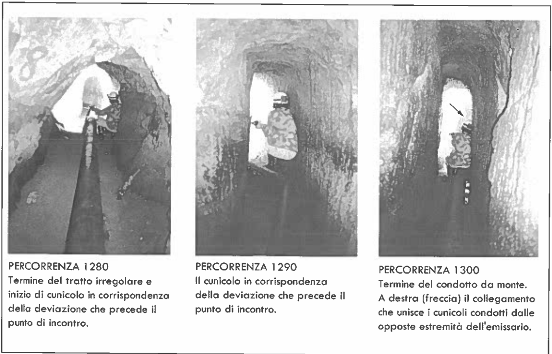
Foto 5.1d: mappatura fotografica del condotto che porta dal II bypass al punto di incontro.
