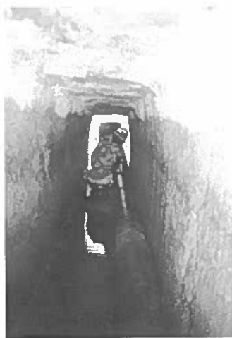
PERCORRENZA 1260 Sezione regolare, leggermente trapezoidale. Sulle pareti segni di scavo molto regolari e continui, intervallati di pochi centimetri.
