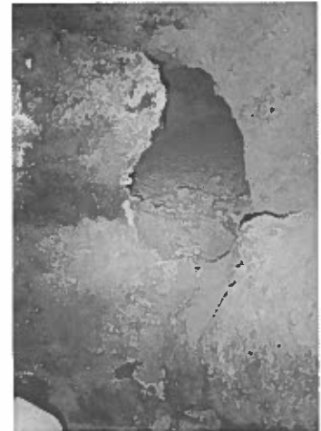
PERCORRENZA 1150 Particolare del muro che chiude il condotto 3. Dietro il muro la prosecuzione del 3. A destra riprende il condotto principale
