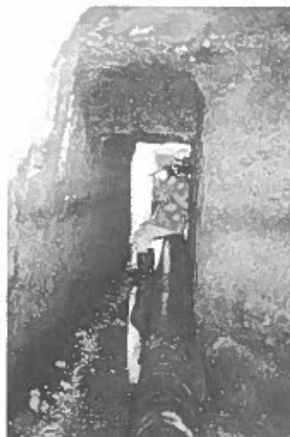
PERCORRENZA 1200 Parte finale di piccolo vano di aggiramento roccia basaltica. Dopo, il cunicolo riprende una sezione rettangolare
