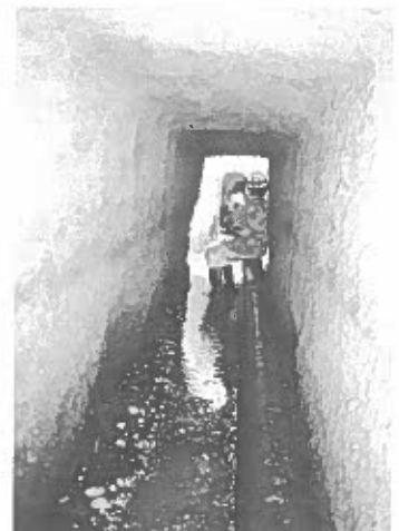
PERCORRENZA 1180 Nella roccia più solida ritorna una sezione tipicamente rettangolare. Fondo coperto da strato calcareo.
