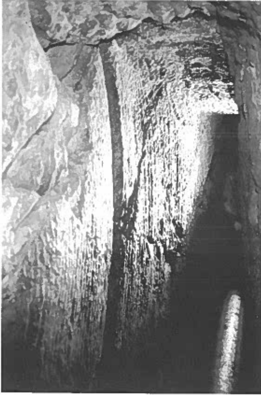
Foto 4.24: tracce di scavo nella parete basaltica in prossimità del punto di incontro (foto V. Castellani).
