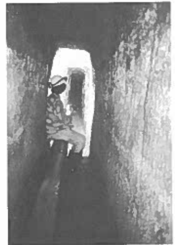
PERCORRENZA 1460 La tipica sezione del tratto regolare in tocce morbide (cfr. fig.19)
