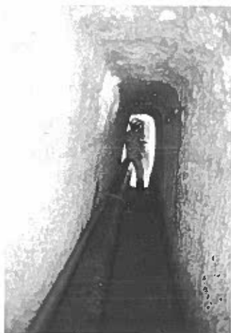
PERCORRENZA 1420 Segue tratto omogeneo, leggera diminuzione della larghezza.
