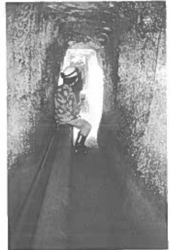
PERCORRENZA 1540 Larghezza del condotto in diminuzione.
