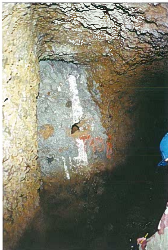
Foto 4.23: l'ingresso murato della prima "deviazione" all'interno del II bypass. Si noti che la volta mostra come in realtà si trattasse dello scavo originario poi abbandonato (foto V. Castellani).
