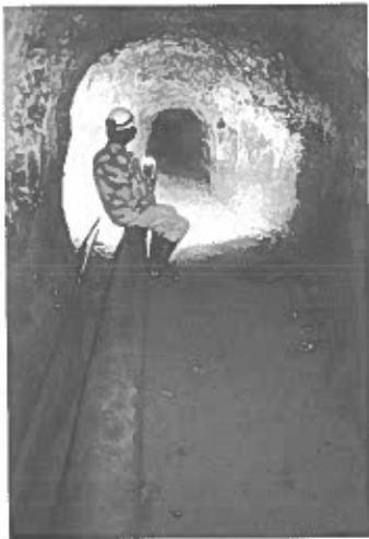
PERCORRENZA 1580 Rozza galleria semicircolare, senza evidenti segni di scavo
