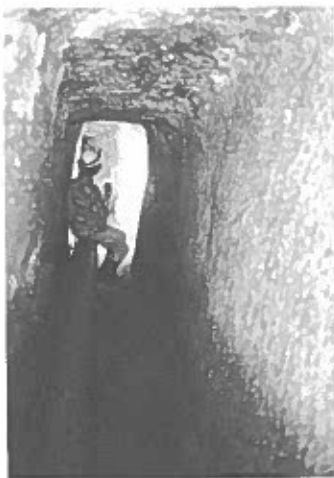
PERCORRENZA 1520 Tratto con leggero abbassamento della volta. Rocce solide, sezione rettangolare.
