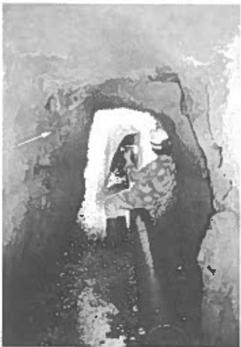
PERCORRENZA 1190 Sulla sinistra (freccia) l'ingresso murato del condotto 5. In primo piano, sulla destra, rocce basaltiche spezzate.
