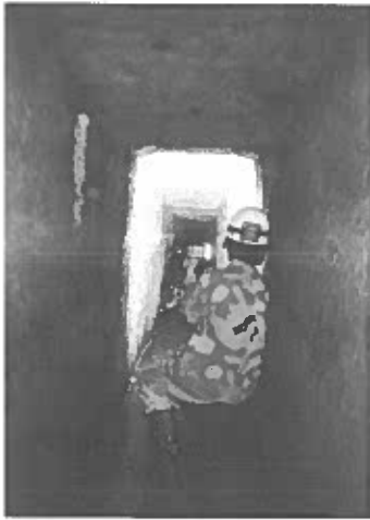
PERCORRENZA 1160 Il primo tratto dopo il II bypass, in rocce di media durezza, ha sezione spiccatamente rettangolare. Sulla parete sinistra la marcatura "1161
