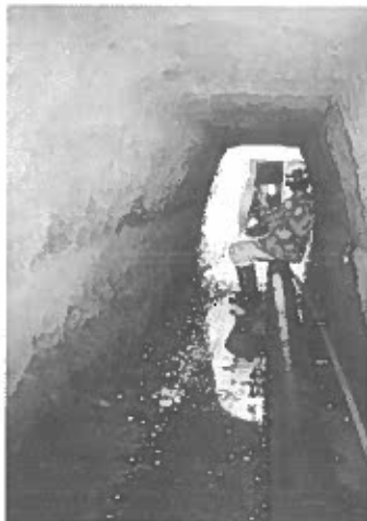
PERCORRENZA 1170 Al passaggio in rocce meno solide il condotto si allarga ad una sezione trapezoidale.
