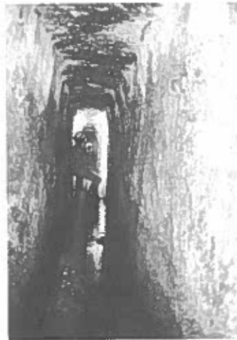
PERCORRENZA 1500 La volta ritorna a 190 cm con una larghezza di circa 70 cm.
