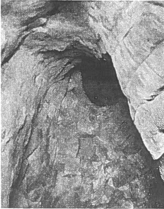
Foto 2.1: il punto di incontro tra i due opposti cunicoli fotografato da valle prima dell'allargamento con la dinamite (da Ucelli, 1930).
