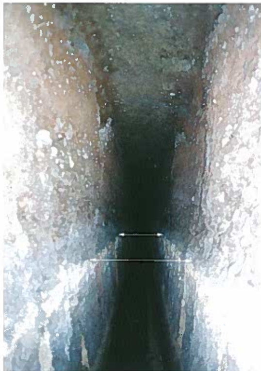
Foto 4.12: dopo l'incontro tra i condotti dell'incile e della discenderia il condotto principale prosegue verso l'interno con andamento spiccatamente rettilineo. Le frecce mostrano la probabile base dello scavo originale (foto V. Castellani).
