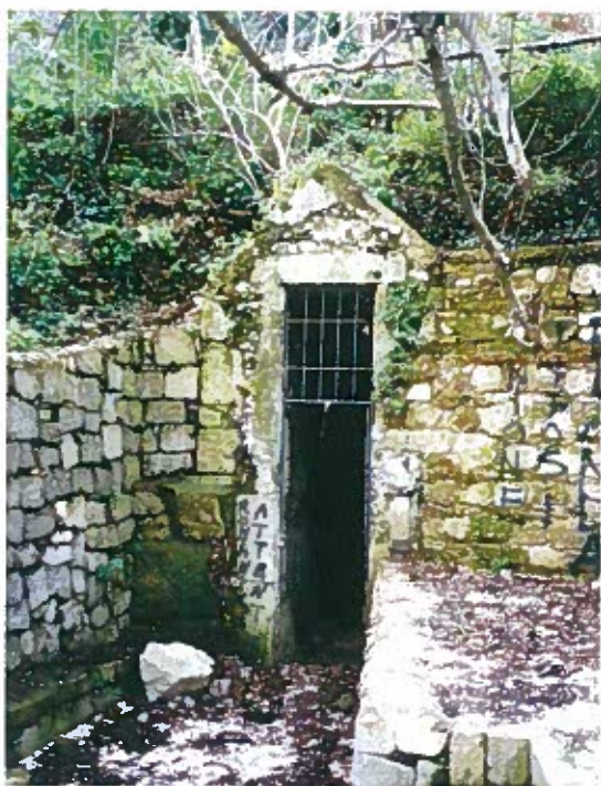
Foto 4.8: l'ingresso dell'incile dopo i recenti restauri (foto V. Castellani).
