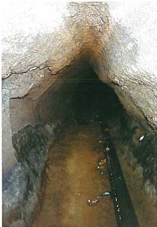
Foto 4.13: tracce sulla volta del condotto ogivale nel tratto che precede il I bypass (foto V. Castellani).
