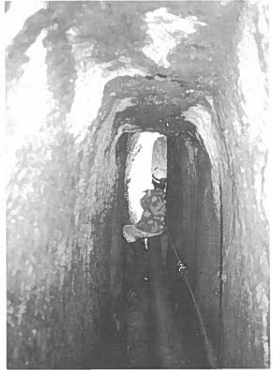
Foto 5.3: la deviazione probabilmente intenzionale del condotto nel ramo proveniente da Valle Ariccia (foto C. Castellani).
