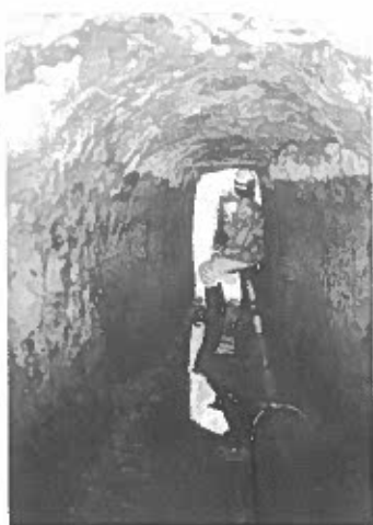
PERCORRENZA 1250 Tratto allargato con rocce irregolarmente frantumate. Il flash illumina l'inizio di un nuovo tratto regolare, a sezione rettangolare.
