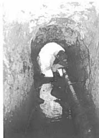
PERCORRENZA 1270 Nuovo tratto irregolare con rocce frantumate e assenza di segni di scavo.
